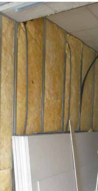
L'isolation phonique entre les pièces est en partie assurée par la mise en place d'une laine de verre acoustique à l'intérieur des cloisons montées de dalle à dalle. Zones de dalles démontables et objets absorbants améliorent le confort acoustique en zone d'accueil.
