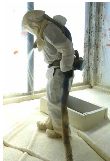
Projection d'un isolant thermique avant le coulage de la chape liquide, dans lequel sont noyés les réseaux d'alimentation des équipements dentaires et coffrage d'une réservation pour recevoir un béton avec armature pour assurer la solidité du sol et les ancrages du fauteuil dentaire.
