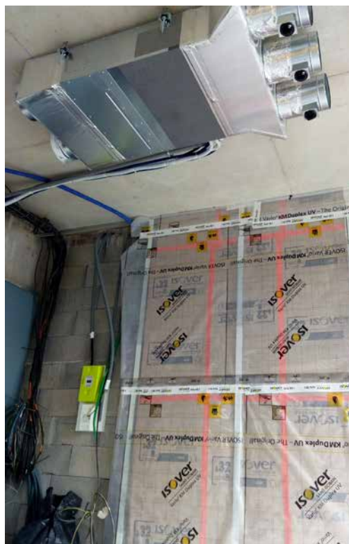
Assemblage de la membrane qui assure l'étanchéité à l'air de l'isolation thermique des murs périphériques.
