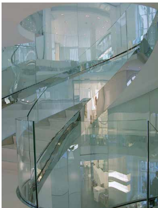
Dans la boutique Dior, rue Royale à Paris. AA Architecture et associés. Verre structurel
