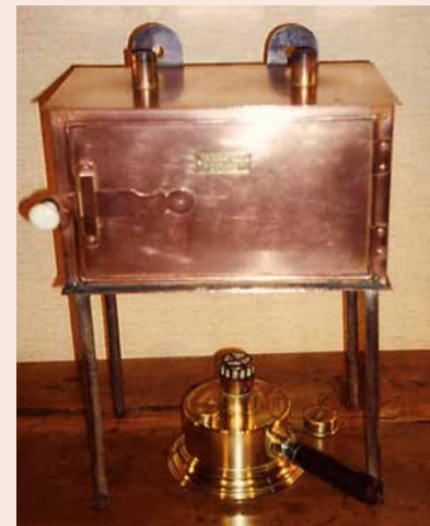
Ci-dessous, stérilisateur à air chaud avec son brûleur à alcool (Cornelsen, 1890).
