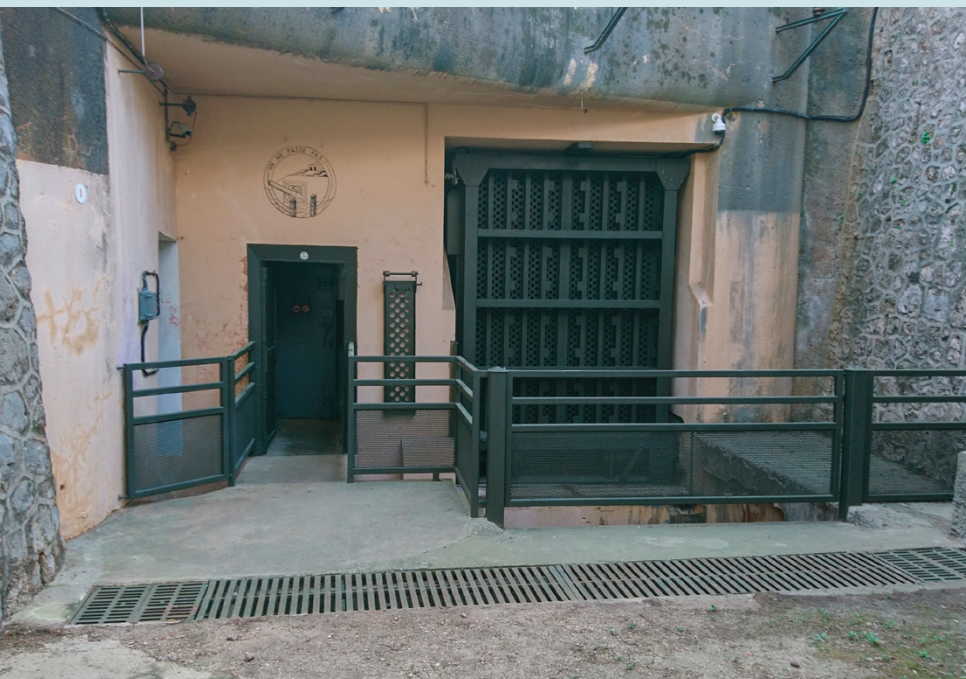
1. Entrée fortifiée de l'ouvrage Maginot du Cap-Martin avec son pont-levis.
