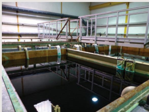
Bains de nickel de la zone d'électroformage.
