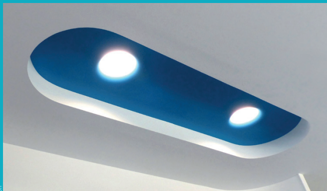
GéluLe en décaissé pour le plafond de la réception d'un cabinet d'orthodontie.
