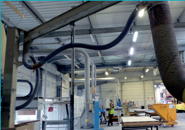
Le système d'aspiration des poussières des machines numériques répond à la réglementation sanitaire.
