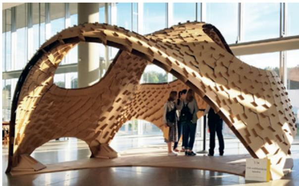
Les quelque 1537 éléments quadrilatéraux uniques de la structure de cette coque (3 mètres de haut et jusqu'à 6 mètres de diamètre), portée sur 5 points, sont en carton ondulé de 3 mm à deux couches.
