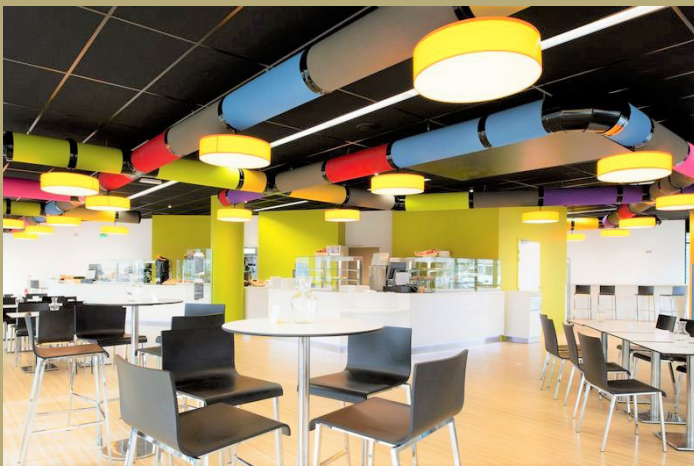
Baffle Absorber Rondo Design avec chemin de câbles et luminaires à l'Université de Grenoble
