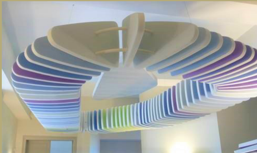
Baffle Absorber Panel Design Picture Classic avec découpe spéciale et impression Pantone pour la création d'un mobile acoustique géant (architecte : La Maison Attentive)
