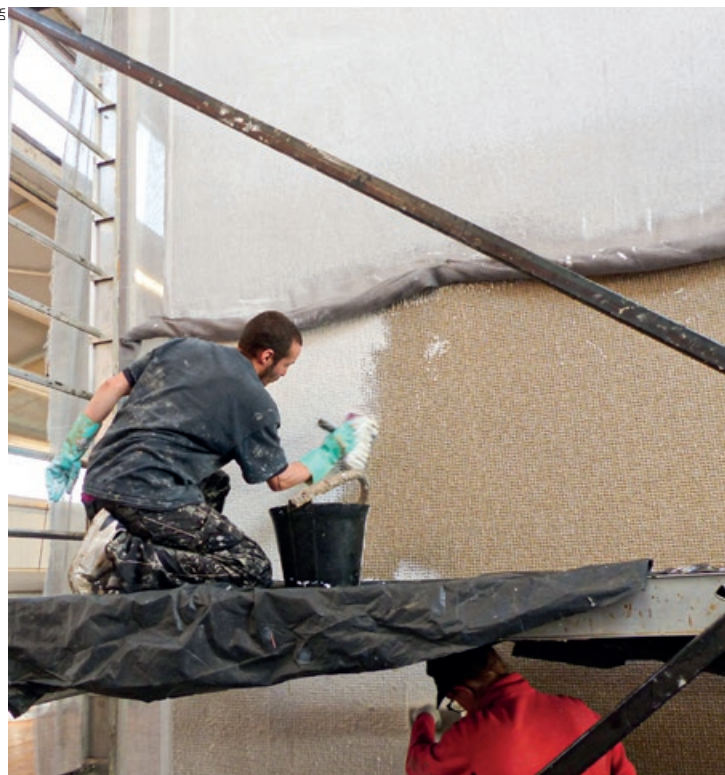
Après retouches éventuelles, contrôle qualité et validation, Laurent pose le scotch de masquage et colle l'arrière de la toile avec une colle à l'eau (le coût de ce procédé est plus raisonnable que celui du nouage à la main).
