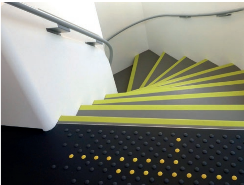
Plots podotactiles et nez de marches contrastants, prolongement des mains courantes au-delà des marches.
