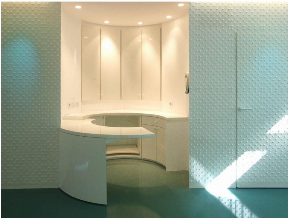
› Logé dans une alvéole hémisphérique contenant des rangements, ce plan accessible en anneau ouvert ne crée pas d'angle saillant dans la circulation.
