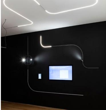
Le système **Turn Around** est composé d'appareils, d'éléments structurels et d'un rail de très petite dimension, adaptables à toutes configurations, créations d'espaces et scénarii d'éclairage. Une bande LED spécifique permet une diffusion uniforme et constante, même en courbe.
